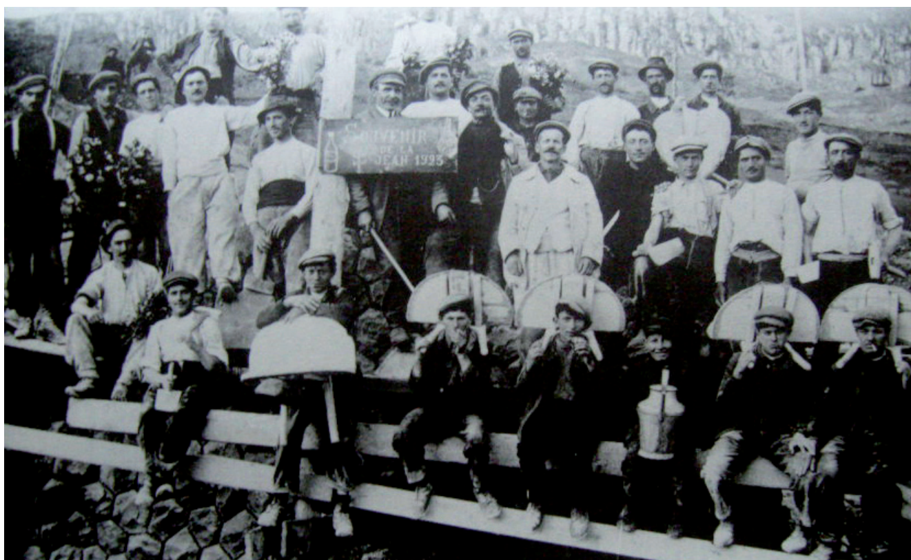
1923 - Les maçons du viaduc réunis à l'occasion de la Saint-Jean, sept d'entre eux portant ce prénom. Sur leurs épaules, au premier rang, la brouette portative appelée « l'oiseau », commune aux maçons à l'époque
